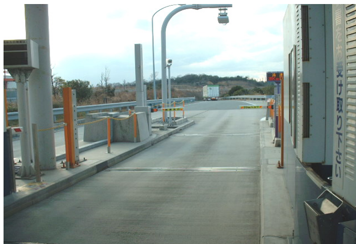
図 14 短尺制御棒の設置状況（両開きの場合・イメージ）
